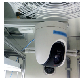
図2 天井部のWEBカメラ
